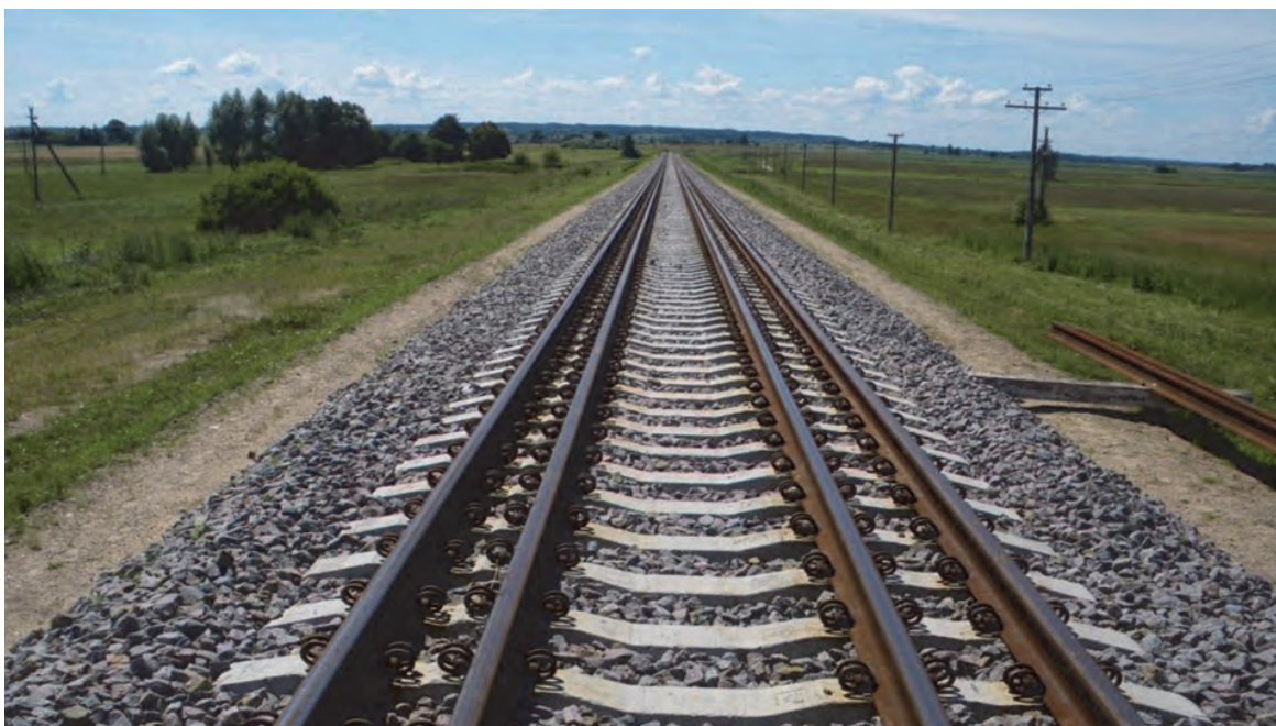
Dual 1435/1520 mm railway gauge line Šeštokai - Mockava Source & Copyright: Lietuvos Geležinkeliai
