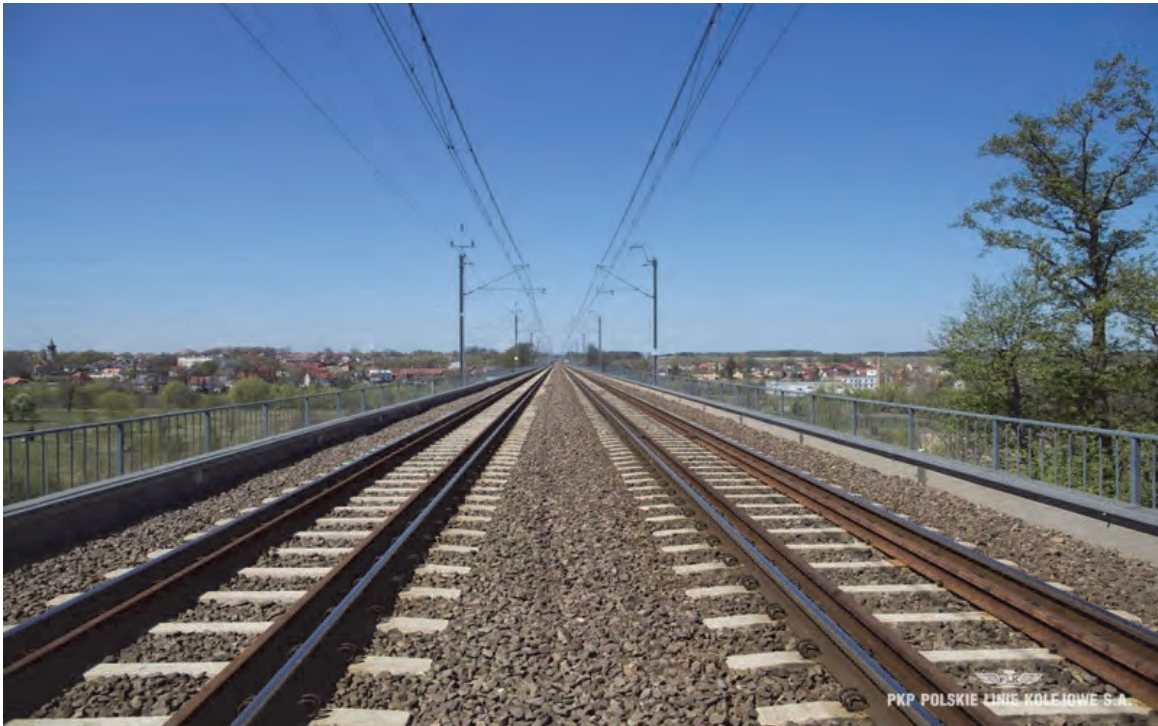
Bridge in Bolesławiec Source & Copyright: PKP Polskie Linie Kolejowe S.A.
